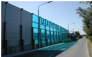
Lärmschutzwand Alte Donau
