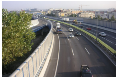
Lärmschutzwand A23 Randstreifenenerneuerung Simmering
