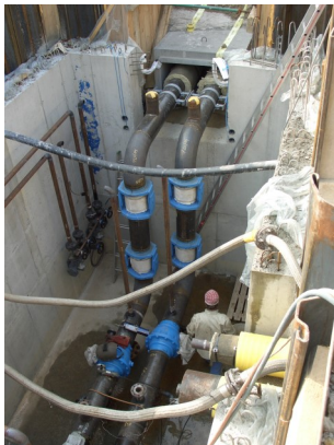
Fernwärmeleitung Franz-Koci-Straße (Wien)
