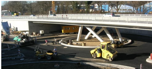
Brücken in Vöcklabruck
