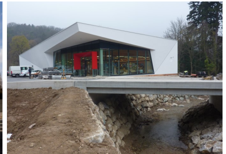
Spar Hinterbrühl: Straße + Verkehr, Tragwerk, Flußbau
